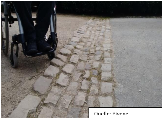
Abbildung 3: Abflussrinne im Eingangsbereich
