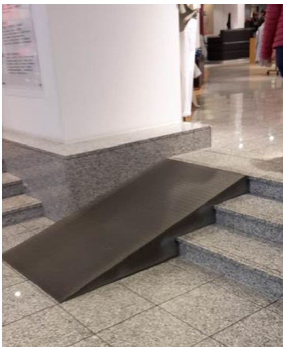
Bild 3: sehr steile Rampe ohne Handläufe. Zudem sehr schmal, ohne Radabweiser
