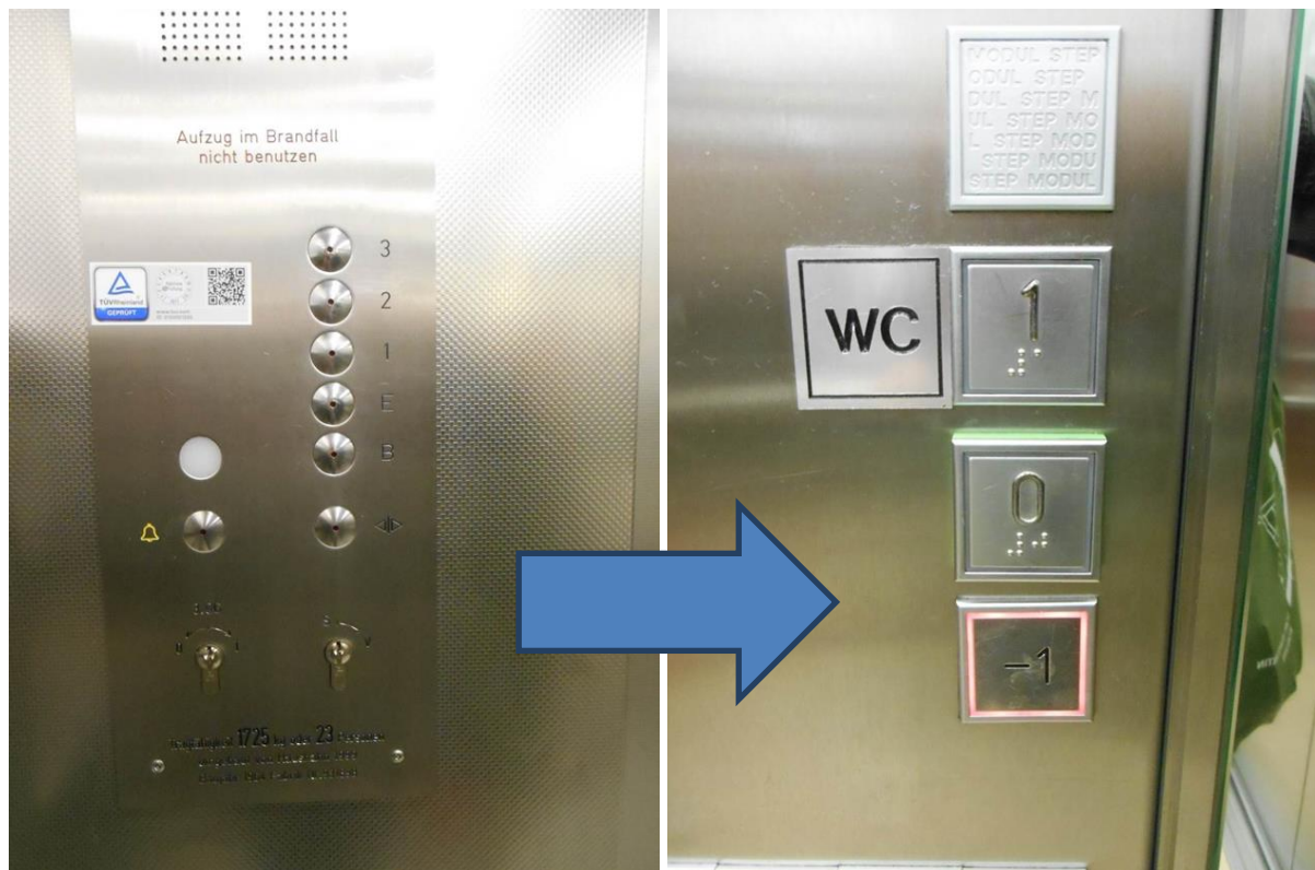
Bild 9: positives und negatives Beispiel für Bedienelemente im Aufzug
