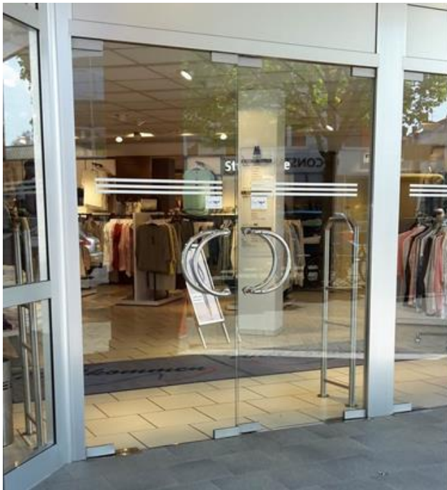
Bild 8: Glastüren mit Kontrastfeldern mit Sichtbereich von Erwachsenen
