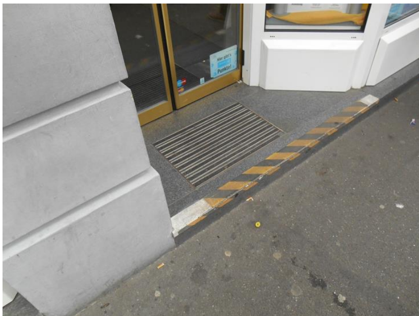
Bild 6: Stufe mit Kontrastfeld, jedoch ohne Handläufe
