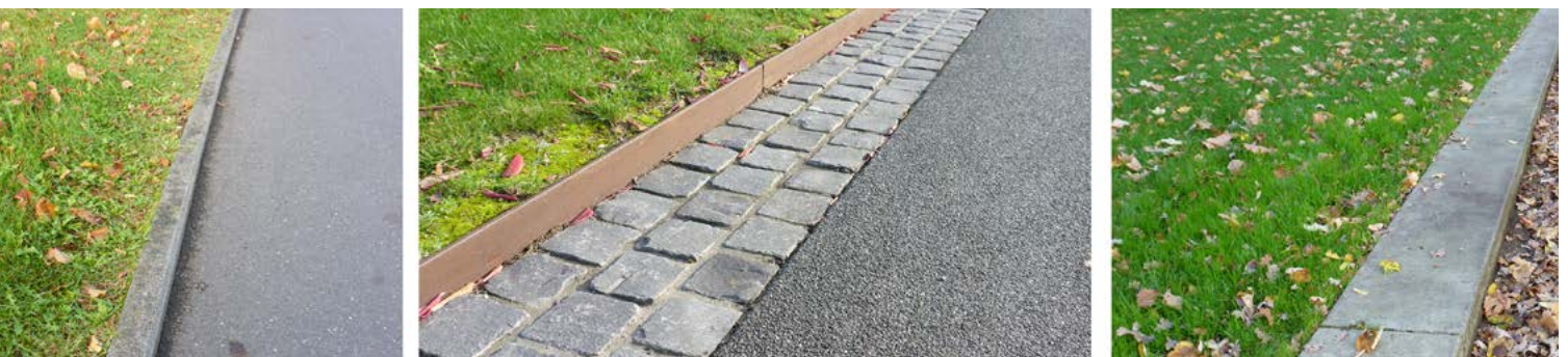
Abbildung 22: Ausführungsalternativen zu taktilen Leitkanten mit einem Betonkantenstein (links) oder mit einer Metallleiste – hier mit einem zusätzlich taktilen Pflasterstreifen kombiniert (Mitte) oder als erhöhter Bord (rechts). Letzteres Foto zeigt, dass sich an taktilen Leitkanten das Laub sammelt und so im Herbst ein erhöhter Pflegeaufwand entsteht. (Quelle: Sweco GmbH)
